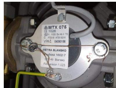
**Присоединение магнитного датчика импульсов
